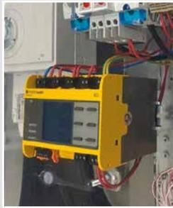
Isolationsüberwachung der 1.000V Strecke, Traforaum zwangsbelüftet
