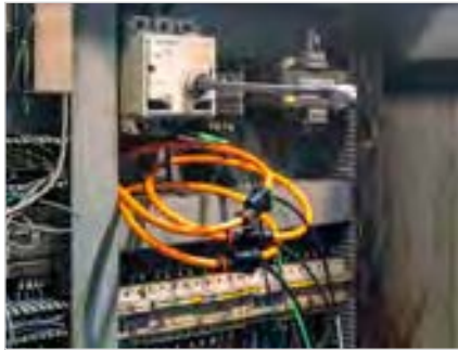
Messung Einsatz der flexiblen Stromwandler
