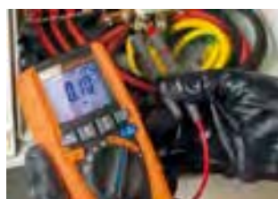
Durchgangsprüfung von Schutzleitern.
