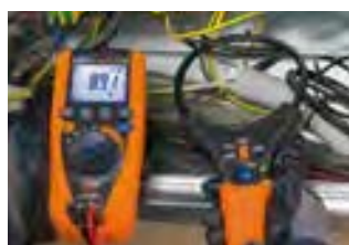
Messung des Stroms mit flexiblem Wandler.
