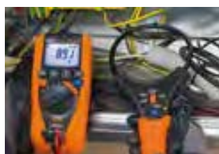
Messung des Stroms mit flexiblem Wandler.
