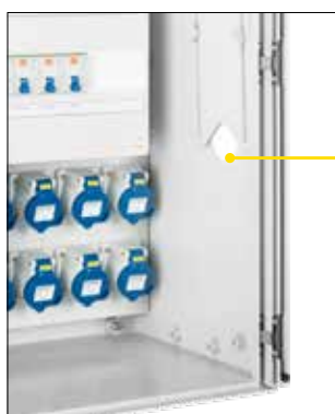
Detail: Schieber in rechter Seitenwand
