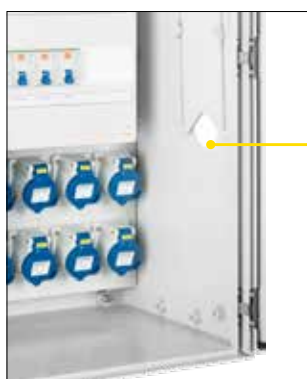
Detail: Schieber in rechter Seitenwand
