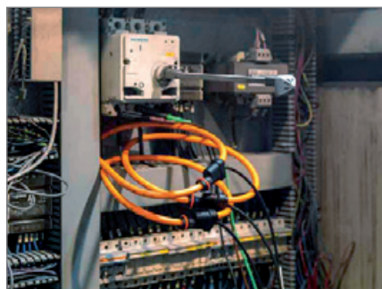
Messung Einsatz der flexiblen Stromwandler
